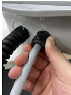
9. Branchez le câble d'alimentation tel comme prescrit par les autorités locales. Dénudez 10 mm d'isolant du câble d'alimentation, serrez toutes les connexions d'alimentation à 1,2 Nm à l'aide d'un tournevis dynamométrique. En bas à droite de la carte de circuit imprimé principale se trouve également une vis avec écrou pour le montage de la mise à la terre avec un collier à anneau.
